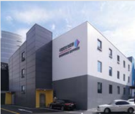
不锈钢预制建筑第6代技术 活楼1.0版 2020年3~5月，为韩国建造2座抵抗新冠病毒的负压隔离病房。此楼为第4座不锈钢芯板活楼
