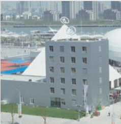
钢结构预制建筑第1代技术 第3幢: 远大馆 上海世博会共有13家企业馆，唯有远大馆保留了15年，2024年12月迁建至上海宝山，此楼一天建成却长久保留，为后世留得绿色世博、科技世博遗产
