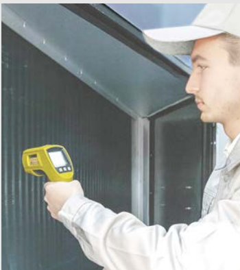
空气热交换器
